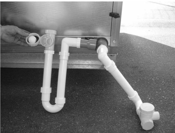
A altura do sifão deve ser ajustada correctamente em função da altura de pressão.
