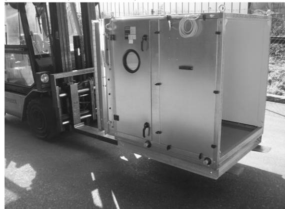
No camião, as peças da unidade têm de ser levantadas cuidadosamente com o desmonta-pneus, para que o empilhador possa aproximar-se.
