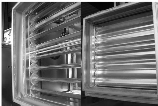
O braço do registo pode ser montado no interior ou no exterior do bastidor. Nas unidades com instalação no exterior, o braço deve ser montado dentro dos limites da unidade ou protegido contra a humidade.
