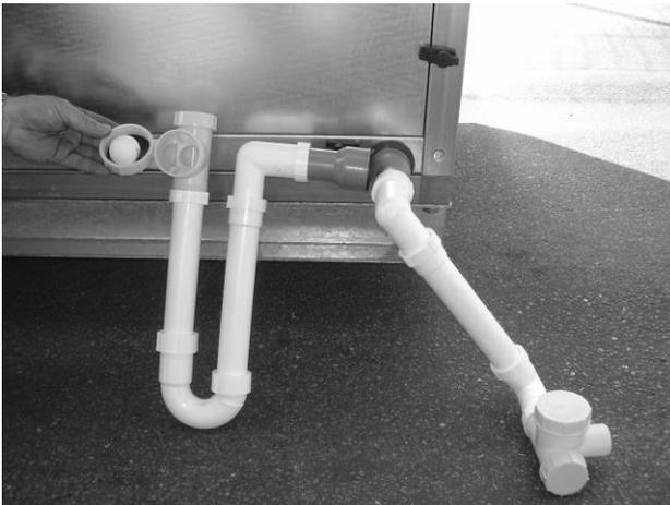
Înălțimea sifonului trebuie dimensionată corect pe baza căderii de presiune.
