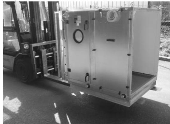
Pe autocamion, componentele aparatului trebuie ridicate cu atenție, folosind levierul de montaj, pentru a permite pătrunderea stivuitoarelor cu furcă.
