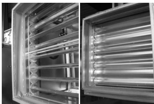
Naprava za podešavanje krilaca u obliku žaluzine može da se montira kako iznutra, tako i spolja na kućištu. Kod uređaja koji su postavljeni napolju, ona mora da se montira unutar uređaja ili mora da se zaštiti od vlage i kiše.
