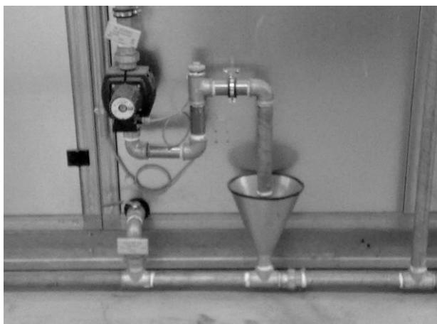
Horizontalni odvodni vodovi u cilju postizanja neometanog odvođenja vode moraju imati dovoljan prečnik, pad, te dovod i odvod vazduha.
