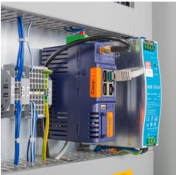
Auch ein GSM-Modul ist ergänzend verfügbar. Nach dem aktivieren ist das Kommunikationsmodul sofort erreichbar. Anwender können dann verschiedene Befehle in der angeschlossenen Steuerung über den Fernzugriff konfigurieren und anschließend über i-connect kontrollieren.
