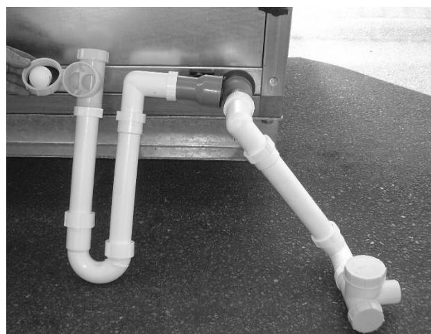
Dimensionner correctement la hauteur du siphon en fonction du niveau de pression.
