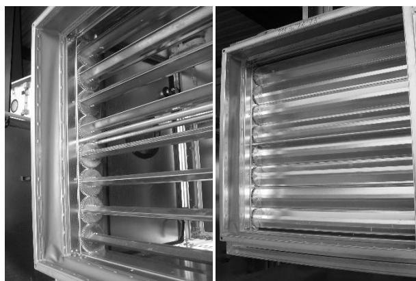
L'actionneur des volets de dosage peut être monté tant à l'intérieur qu'à l'extérieur sur le caisson. En cas de machines installées en extérieur, le monter à l'intérieur de la machine ou le protéger de l'humidité.
